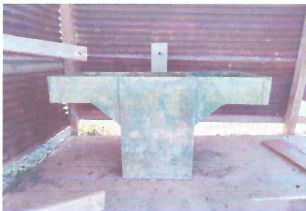
Foto 3: FALTA DE AGUA POR EL CHORRO
